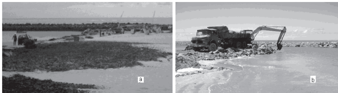
Figura 1 – Fotos da Praia de Candeias, Jaboatão dos Guararapes – Pernambuco: (a) espigão coberto pela areia da praia e quebra-mar ao fundo (ago/2004) e (b) retirada do espigão perpendicular à praia, permitindo a circulação da água na área interna do quebra-mar.
